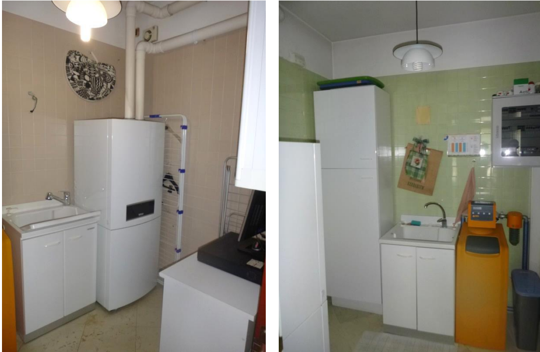
Abitazione mappale 207 sub. 55-57 – Locali Centrale Termica
