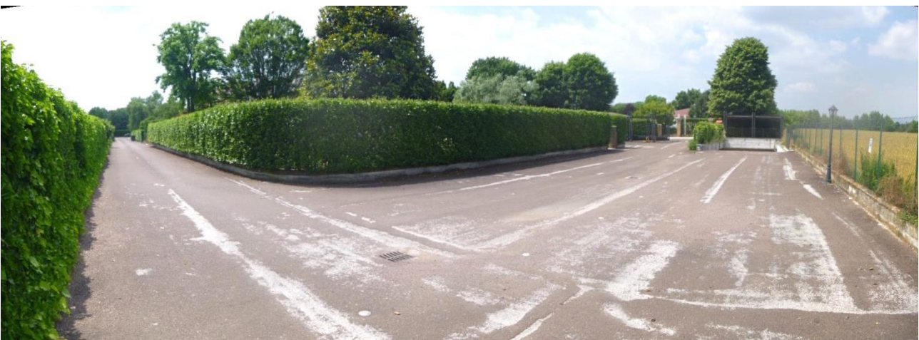
Complesso "Residence Antico Casale" – strada carraia e pedonale di pertinenza dei Blocchi B-C (sub. 7)
