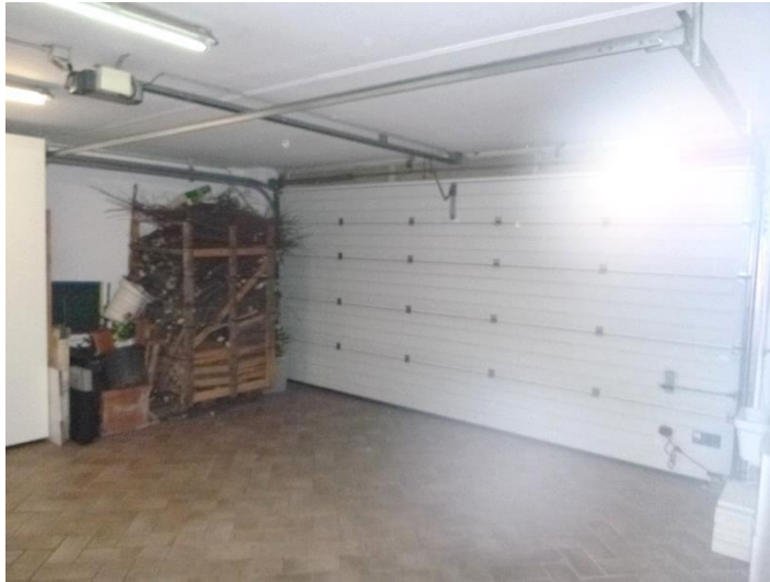
Complesso "Residence Antico Casale" – interni autorimesse
