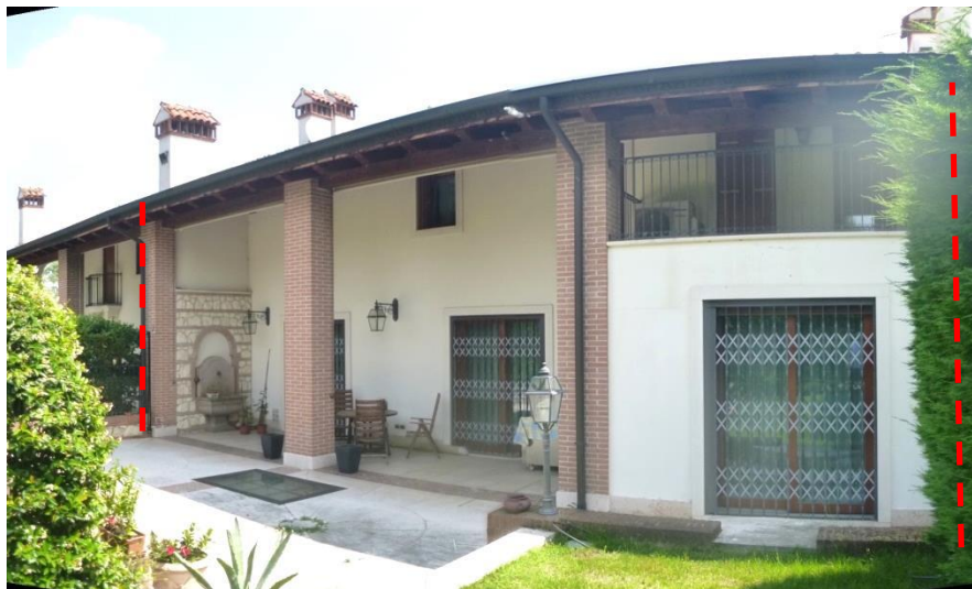
Abitazione mappale 207 sub. 55-57 – Prospetto Ovest
