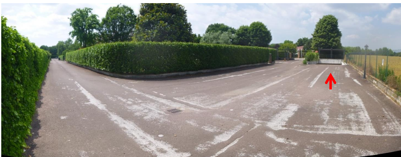
Complesso "Residence Antico Casale" – piazzale comune sub. 7 di accesso alle autorimesse
