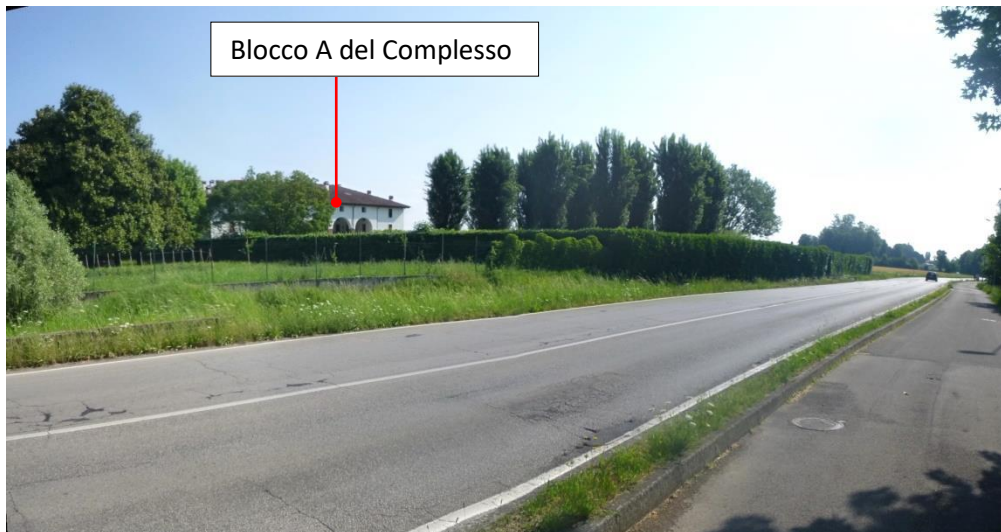
Complesso “Residence Antico Casale” – lato Sud/Ovest fronte Strada di Bertesina
