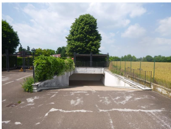
Complesso "Residence Antico Casale" – rampa scivolo di accesso alle autorimesse
