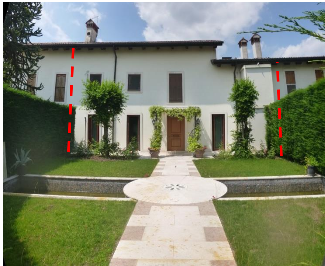
Abitazione mappale 207 sub. 55-57 – accesso dalla corte Est / Prospetto Est
