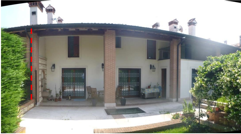
Abitazione mappale 207 sub. 55-57 – Prospetto Ovest
